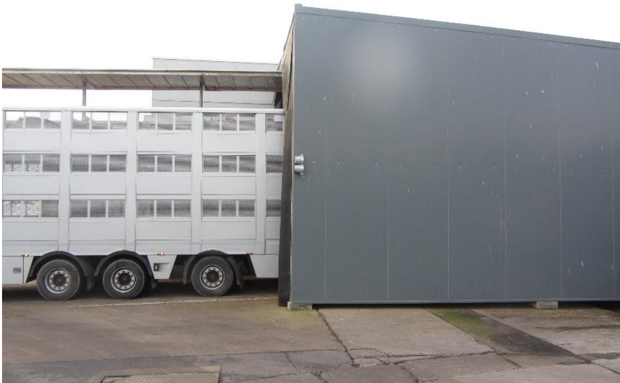
Figuur 6: loskade voor varkens, het losproces is afgeschermd van de buitenomgeving zodat eventueel storende zonnestrallen of omgevingsgeluid geen of nauwelijks impact hebben.
